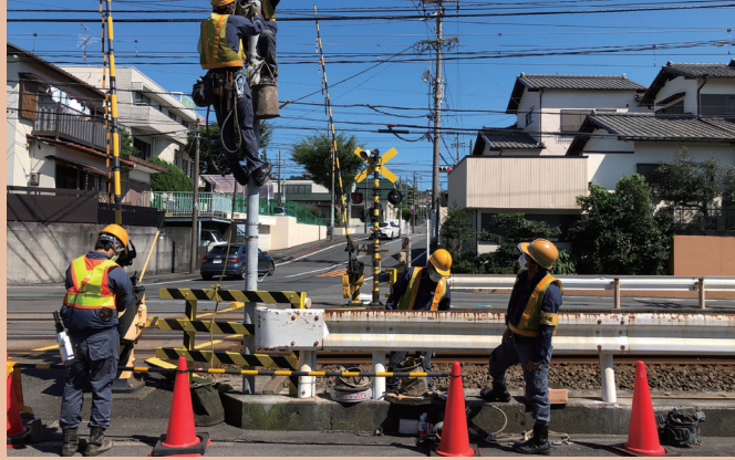
踏切設備の安全点検
